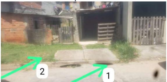
Eliminar Tampa da figura 1 e passar para O lado esquerdo, figura 2.
